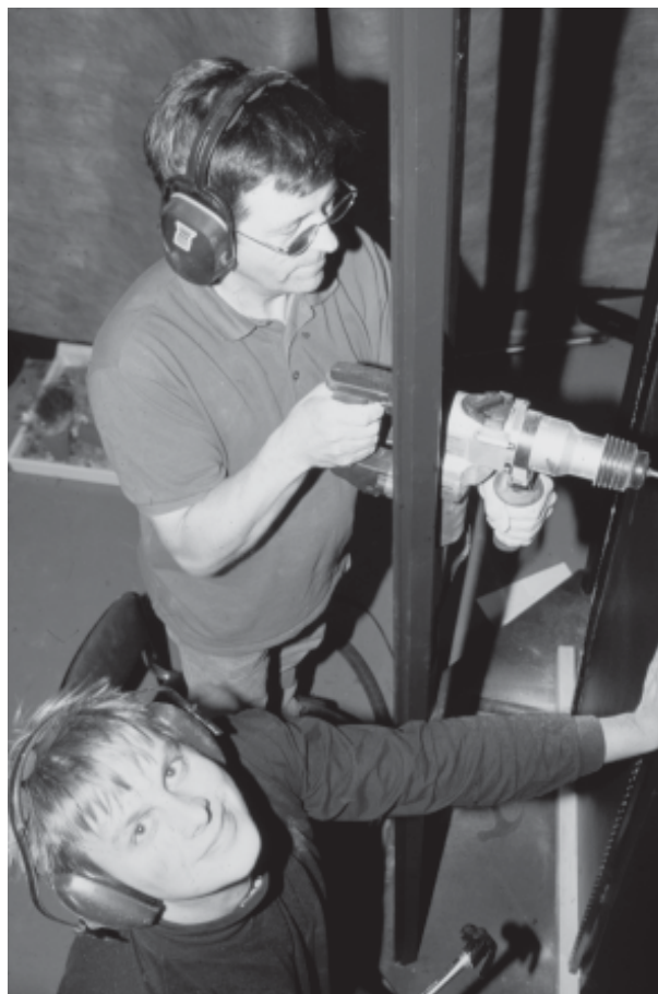
Lintutorni, johon ei voi kiivetä. Lajitornia rakentamassa museomestari Tapani Kahila ja puuseppä Mika Hirvonen.
