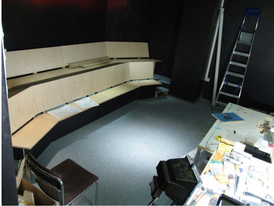
Toimintatila rakenteilla. Toimintakertomusvuonna valmistuivat tilan perusrakenteet. Tilaa täydennetään tulevana vuonna opetusvälineillä ja -materiaalilla. Kuva: Tapani Kahila.
