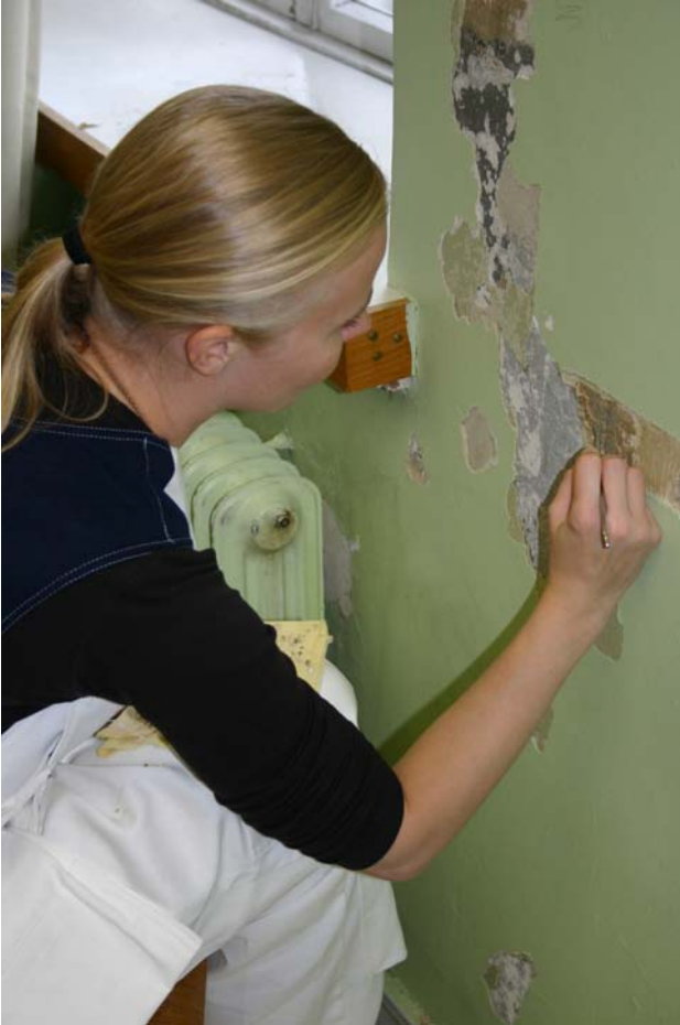
Erikoismaalari Riikka Koskinen Sellakka Oy:stä teki S-rakennuksessa värikerrostumien esiinottoja. Kuvassa hän selvittää alkuperäisiä koriste-maalauksia luokassa S305. Kuva: Sanja Jalonen.
